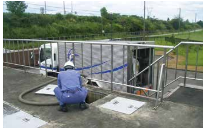
汚水処理施設での汚泥抜き作業
